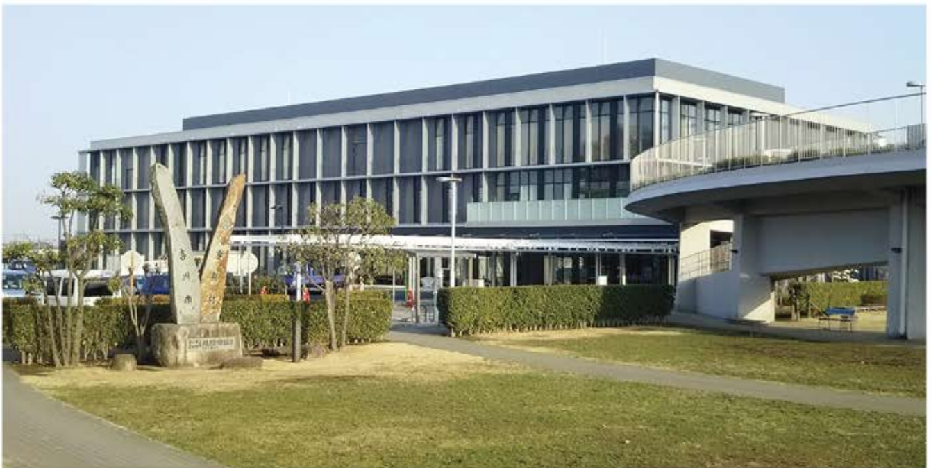
吉川市役所新庁舎(吉川市役所提供)
